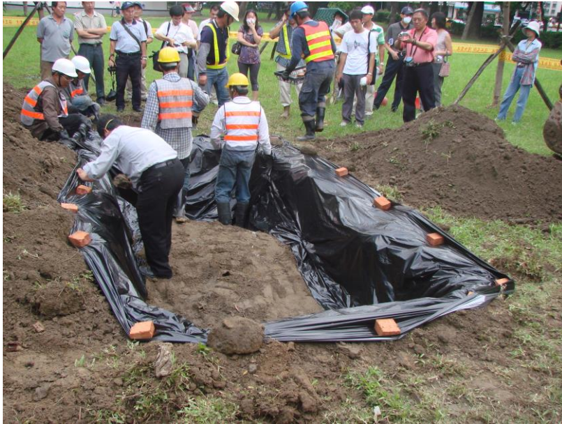
圖十三、設置阻絕溝。
