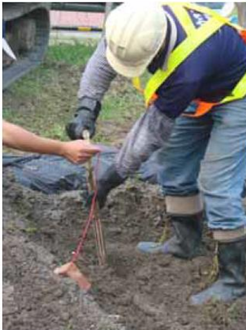
圖十五：埋入檢驗用的標記。
