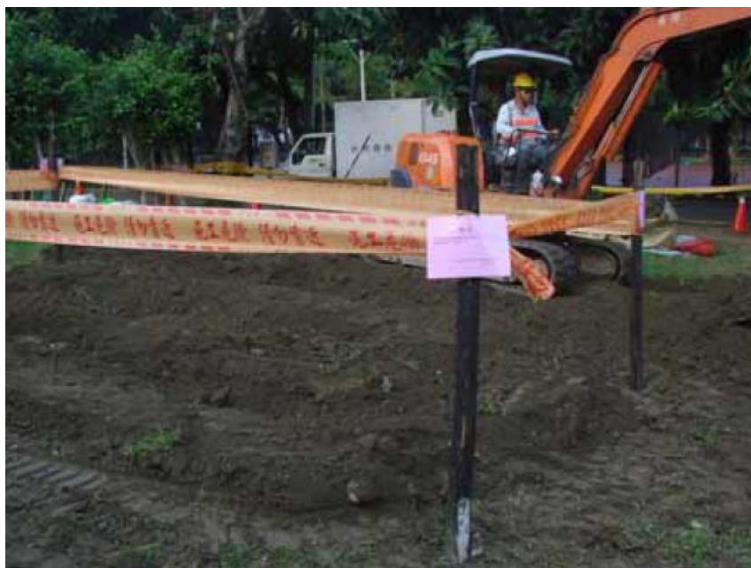
圖十七：燻蒸處理地區需以圍籬進行區隔。
