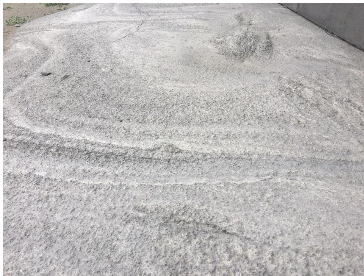
圖 3.1 中聯台中廠區鋪設滾筒轉爐石 CLSM (107 年 3 月 1 日拍攝)
