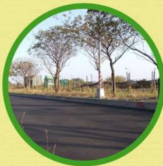
瀝青混凝土 鋪面(爐渣)
