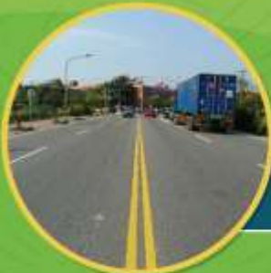
新生路至崁頂路道路拓寬工程 以底渣作為道路底層改善後照片
