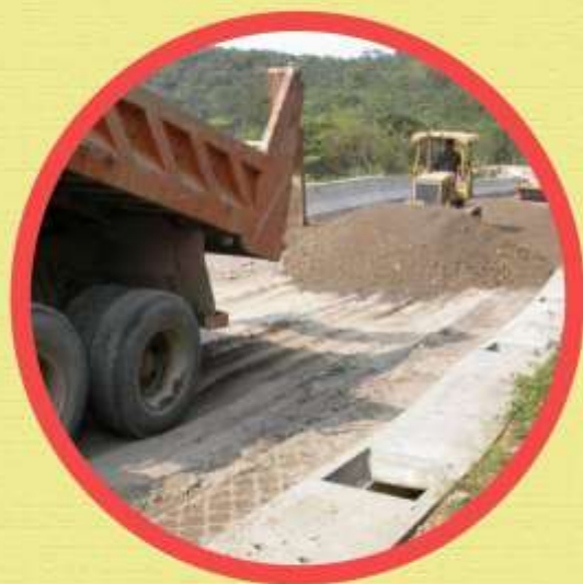
道路工程 基底層(底渣)
