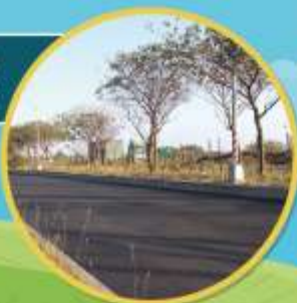
南星路以轉爐石瀝青 混凝土改善後照片
