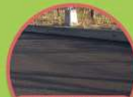
瀝青混凝土 鋪面(爐碴)
