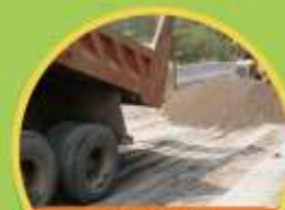
道路工程 基底層(底渣)
