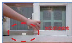
窗戶加裝鋁窗檔塊，限制窗戶開啟寬度不超過 10 公分
