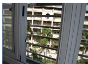
在走廊邊間處之窗戶為水平式推拉窗戶，設置橫式欄杆，且欄杆間隔小於 10 公分
