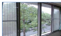
推拉式窗戶加裝防壁圍籬，且圍籬最大拉寬不超過 10 公分
