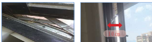
外推式窗戶裝設門止器、安全鎖，限制窗戶開啟寬度小於 10 公分
