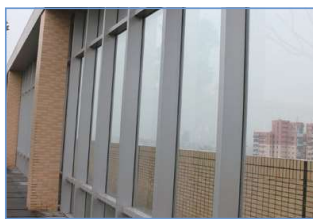
頂樓除加裝欄杆，並於欄杆間加設強化玻璃
