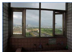
在走廊邊間的窗戶為外推式窗戶，加裝開啟停止之裝置，限制窗戶開啟之寬度為 10 公分
