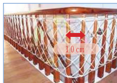
欄杆間隙超過 10 公分，應加裝安全防壁網
