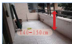
陽臺、露臺欄杆高度建議為 140-150 公分，提高防壁效果
