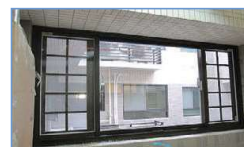
推拉式窗戶加裝防壁格柵，且隔柵最大拉寬不超過 10 公分
