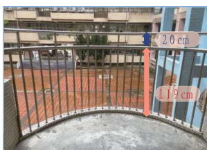
部分走廊設置直式欄杆，欄杆總高度為 139 公分，另欄杆間隔小於 10 公分
