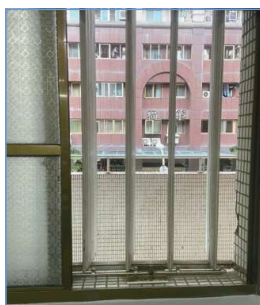
為強化防壁，於水平式推拉窗戶之外牆開口部加裝直式百葉窗
